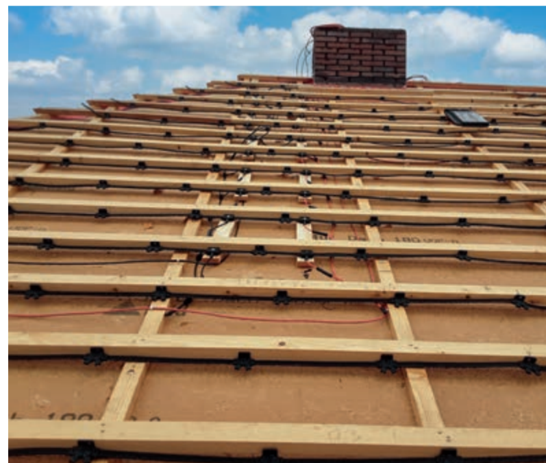
Nicht nur das Dach wurde klimafreundlich: Vor der Verlegung der Solardachziegel mit PV-Modulen erfolgte die Dämmung mit Holzweichfaserplatten.
