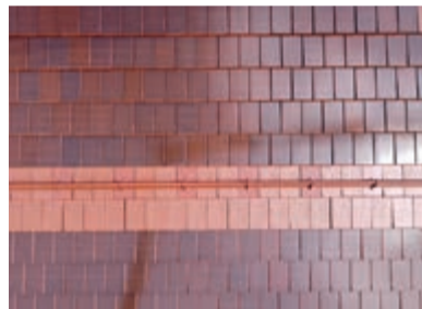
Im Produktionsprozess werden Ziegel und Solarmodul untrennbar zu einer Einheit verbunden.
