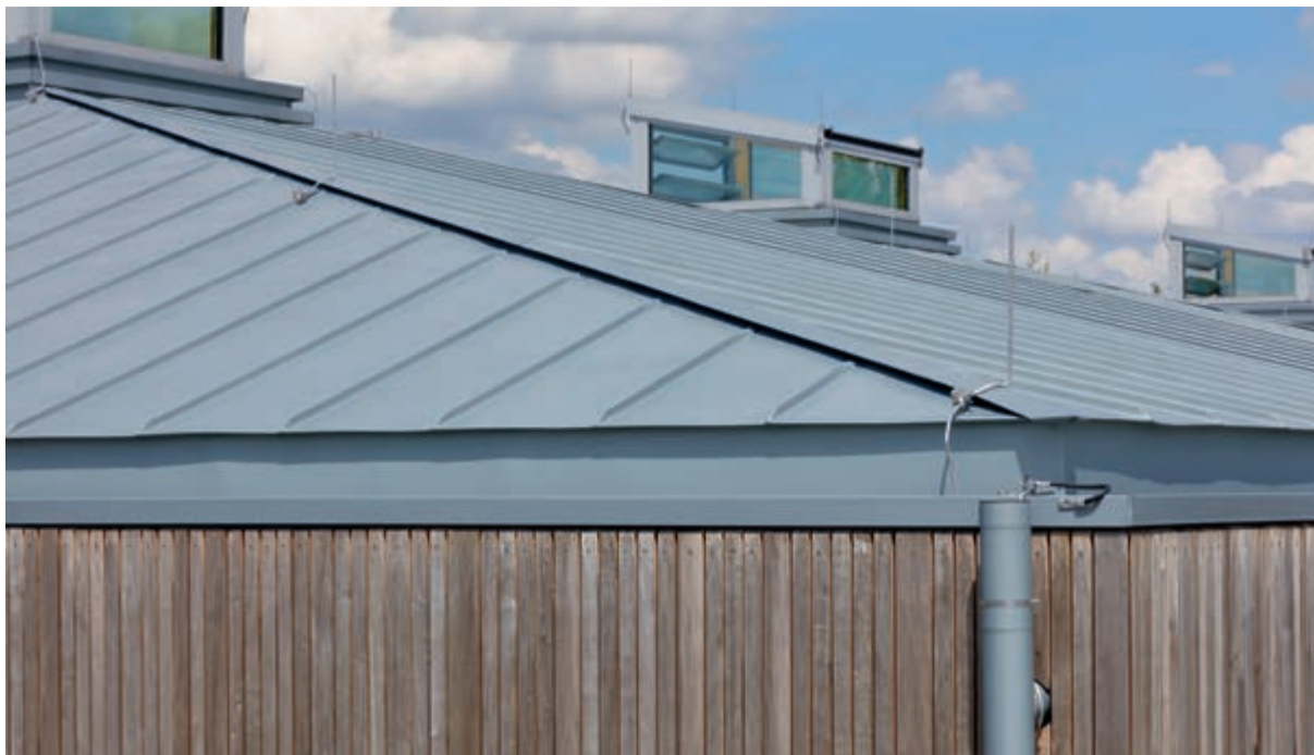
Kindergarten Johanna in Alfhausen mit einem Dach aus Titanzink in der Oberflächenqualität prePATINA blaugrau von RHEINZINK.
