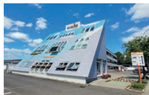
Das bunte Dach des Ausstellungsgebäudes vor dem Umbau.
