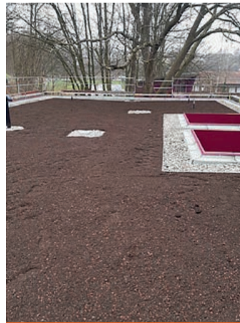
Kiesstreifen in den Anschlussbereichen mit Kiesfangleiste BauderGREEN.
