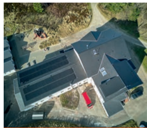
Blick über das fertiggestellte Dach des Haus Sonnenau.
