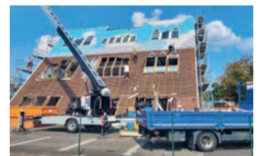
Das gesamte Gebäude wird energetisch saniert.
