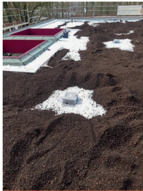
Anschließend erfolgte das Aufbringen der Vegetationstragschicht.
