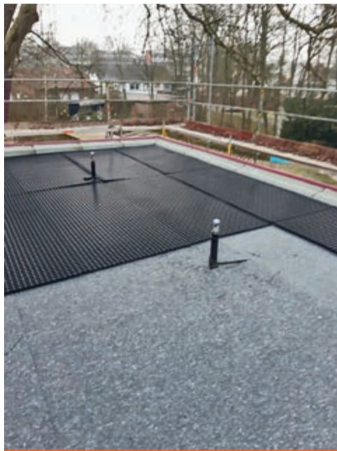
Erste Schicht als Schutzlage und das Drän- und Speicherelement von Bauder.
