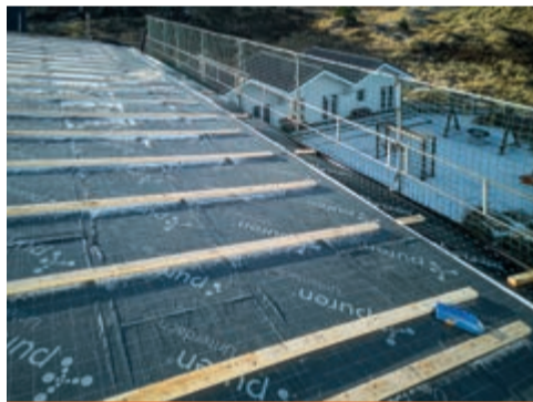
Über die notwendige Konterlattung werden die PU-Dämmstoffplatten mittels passender Systemschrauben im Untergrund fixiert.
