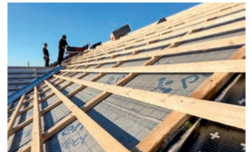
Vorbereitung für die Deckung der Steildachflächen.
